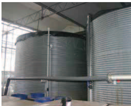
Op alle drie locaties wordt de opslagcapaciteit van de silo's verdubbeld.
